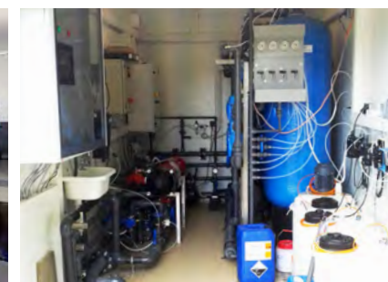
Kontejnerska izvedba peščene filtracije za pitno vodo (Severna Makedonija)
