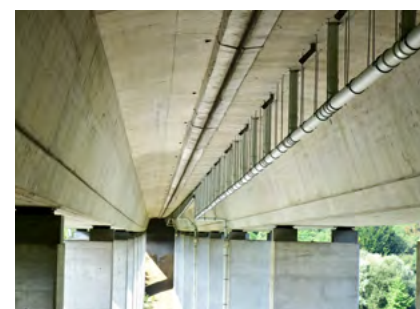
Sanacija odvodnjavanja na viaduktu Lijak (Slovenija)
