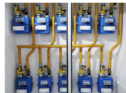
Daljinsko odčitavanje plinomerov in daljinski nadzor ključnih kupcev LoRaWAN, GSM, NB-IoT za Dukom Plin, Dugo Selo (Hrvaška)
