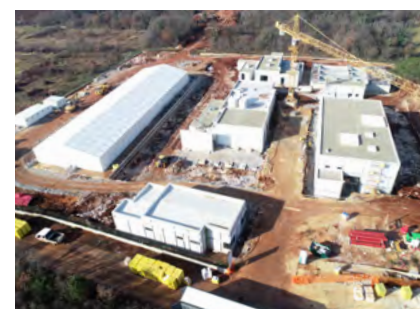
Montaža tehnološke opreme in izdelava strojnih inštalacij, Centralna čistilna naprava Poreč (Hrvaška)
