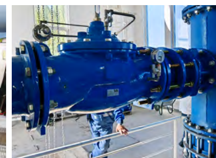
Izdelava regulacijskega in merilnega jaška z elektromagnetnimi merilniki pretoka in avtomatskimi regulacijskimi ventili, WS Skopje (Severna Makedonija)
