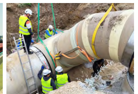
Montaža opreme in cevni razvodov ter izvedba elektro inštalacij, Centralna čistilna naprava Ljubljana - III. faza (Slovenija)
