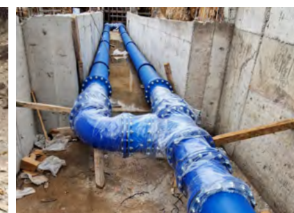
Rekonstrukcija glavnega vodovoda-1 v Občini Štip, DN 400 (Severna Makedonija)
