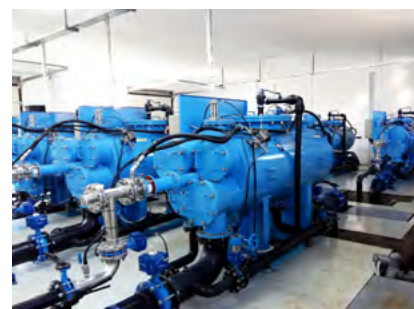
Mehanska mikro filtracija na vodovodnem omrežju Gostivar (Severna Makedonija)
