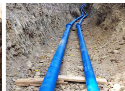
Izgradnja vodovodnega omrežja Tolminski lom, preizkusni tlak 63 barov (Slovenija)
