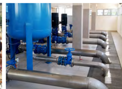
Izgradnja 11 črpalnih postaj za kanalizacijo v Herceg Novem (Črna gora)
