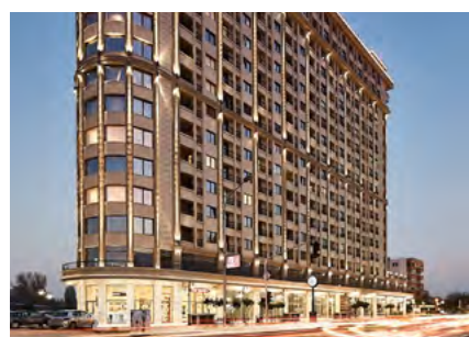
Sprinkler sistem in črpalna postaja v stanovanjsko-poslovnem kompleksu Adora Flatiron Skopje (Severna Makedonija)
