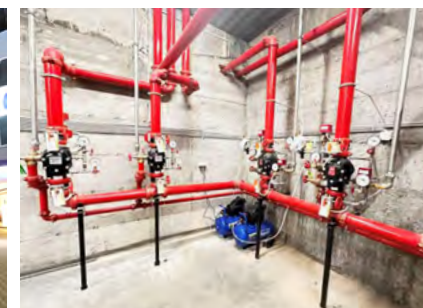
Dobava in vgradnja sprinkler sistema (mokri in suhi tip) v Trgovskem centru Belamionix, Tuzla (Bosna in Hercegovina)
